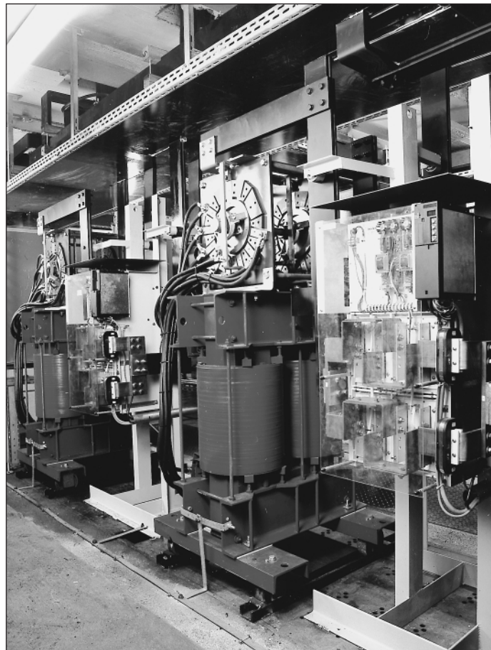
Bild 3: Leistungssteller Thyro-M Typ 1M 500-3000HF mit Anpaßtransformator Fig. 3: Thyro-M Type 1M 500/3000HF power controller, showing matching transformer
