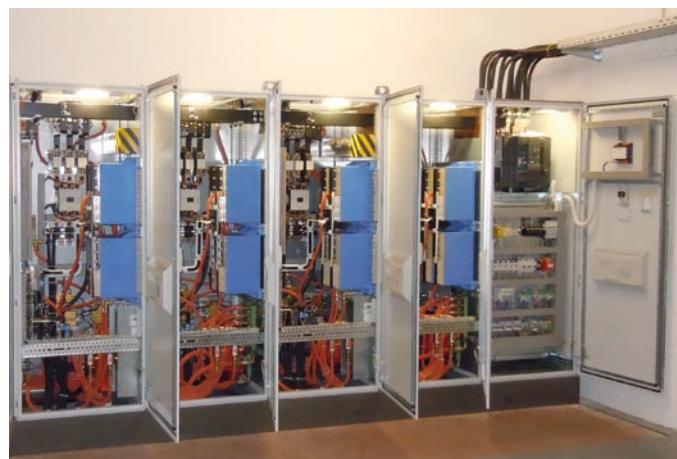
Bild 7: IGBT-Umrichter mit vier Ausgängen
